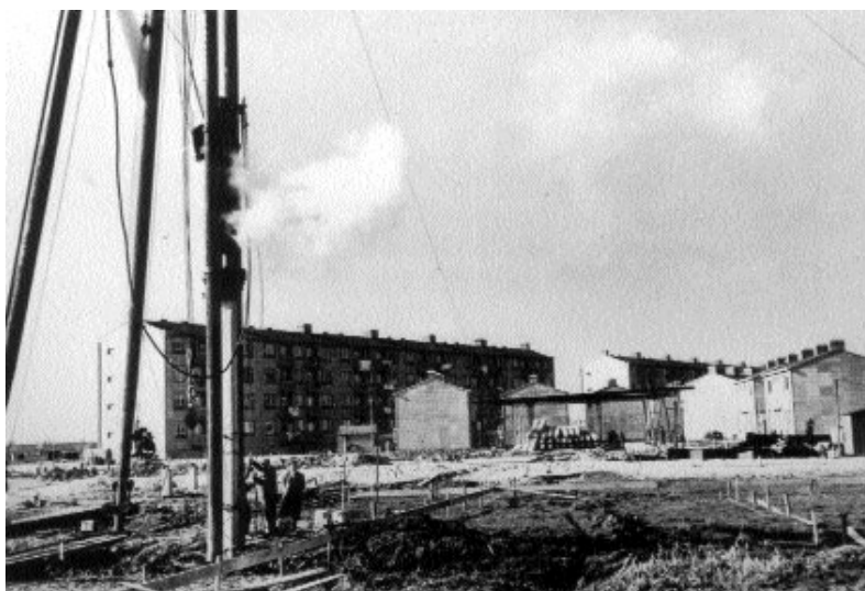
Heiwerkzaamheden aan de Nederhorst, Zuidwijk
